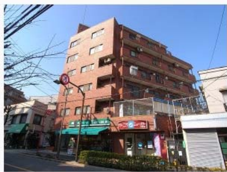
レンガタイル貼の外観
